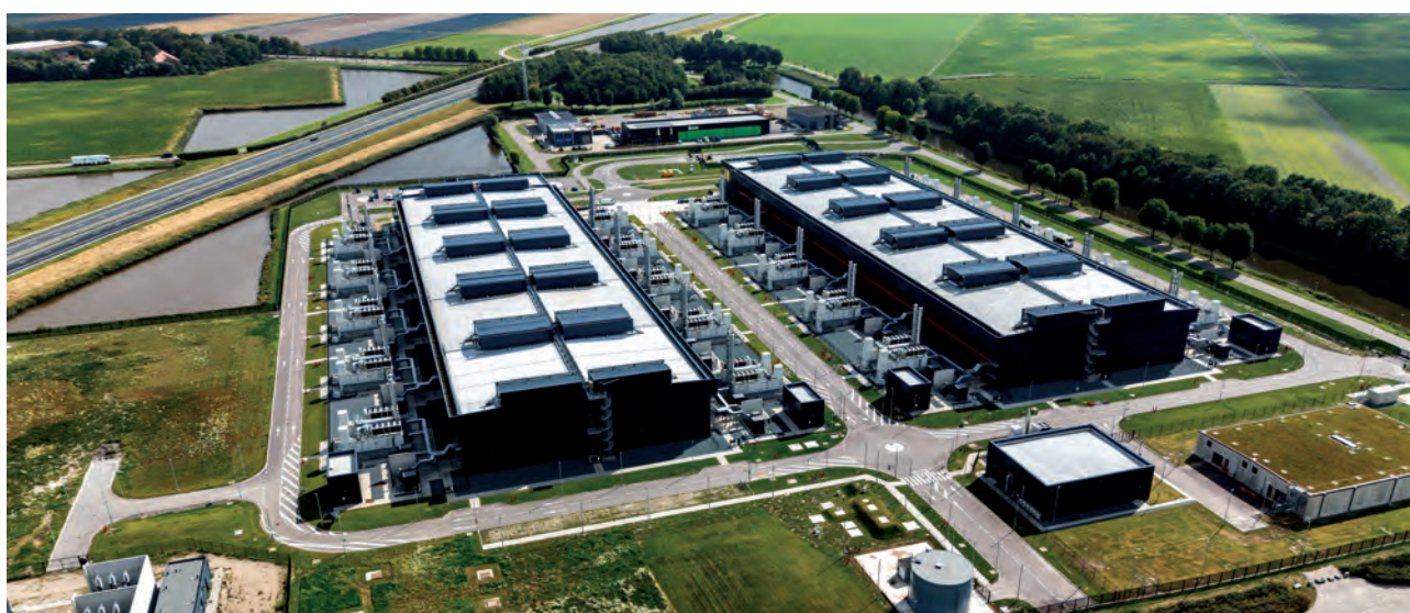
Deutschland möchte sich zum attraktiven Standort für Rechenzentren entwickeln: im Bild die Microsoft-Data-Center AMS13 und AMS14, die 2023 und 2024 in den Niederlanden errichtet wurden
